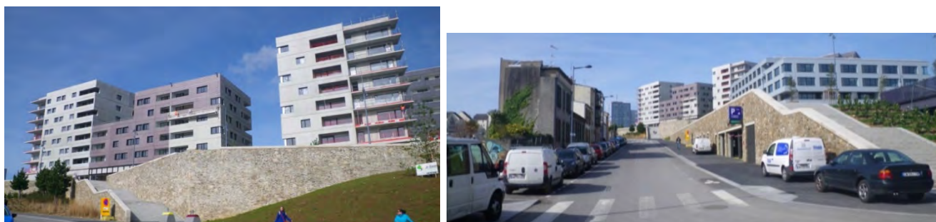
Les nouvelles constructions de la ZAC des Capucins – vues depuis la rue du Carpont – Photo Brest métropole 05/2017
