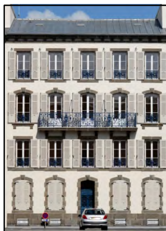
Construction d'inspiration classique à ornementation
