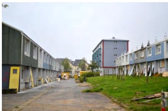
Démolition de l'îlot Nungesser – Photo Brest métropole
