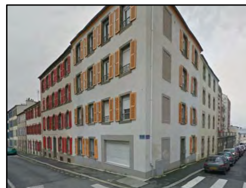
Construction d'inspiration classique simple
