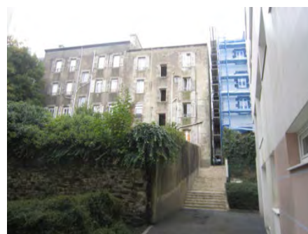
Façades d'immeubles en cœur d'îlot Photo Brest métropole
