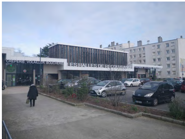
La place sert de parvis aux halles de Recouvrance.
