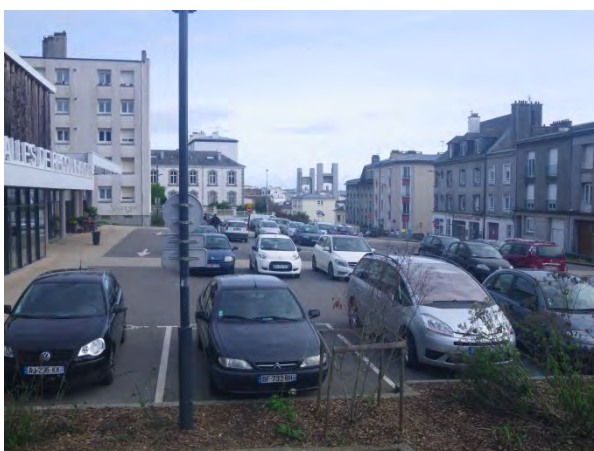
Le haut des piliers du pont de Recouvrance est visible depuis l'espace René le Saëc, servant ainsi de point de repère.
