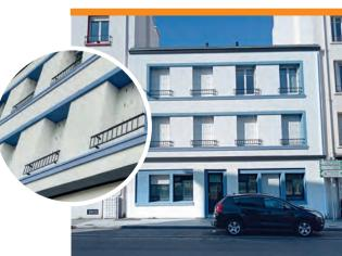
On peut redessiner ces détails soit par l'ajout d'éléments en surface (profilés moulurés en polystyrène), soit par une surépaisseur d'enduit ou encore par une couleur différente....
